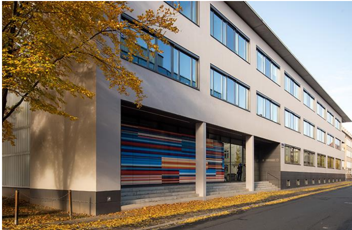
Abb. 3: Mfpa Weimar – Hauptgebäude
